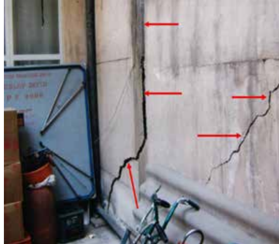
تصویر شماره ۱- ترک های ایجاد شده در دیوار حیاط، ناشی از نشست ساختمان مجاور
