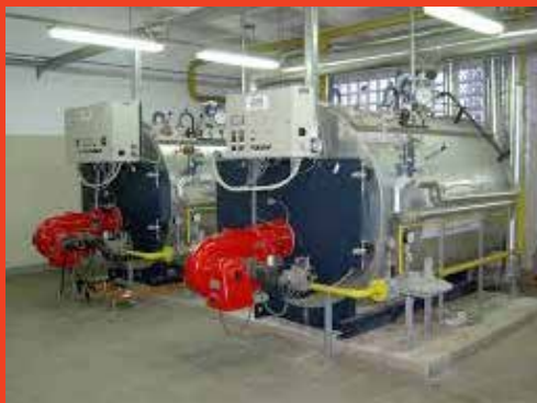
شکل ۱: نصب بویلر روی فونداسیون
