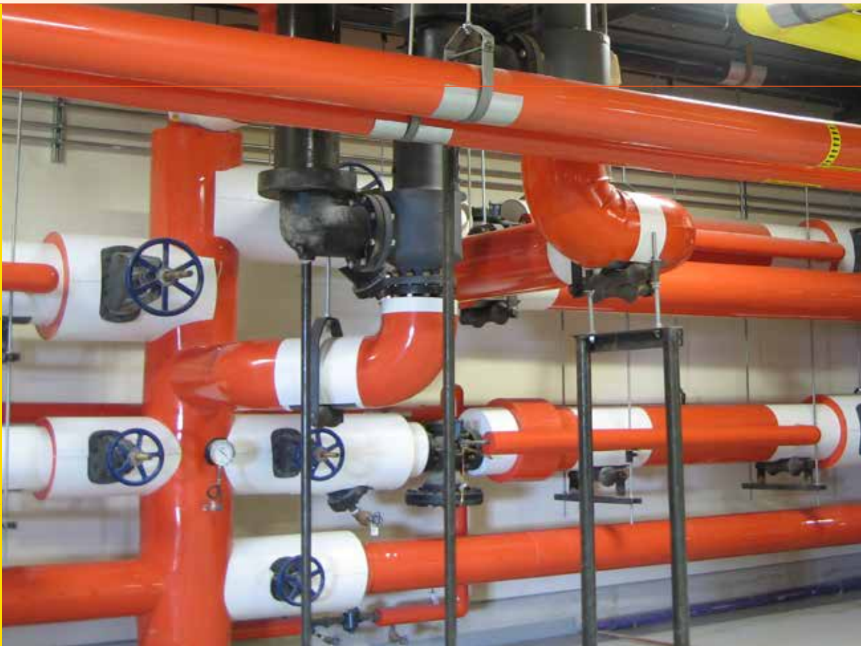
شکل ۳: به کار گیری رنگ در شناسایی مسیر سیال های مختلف در موتورخانه
