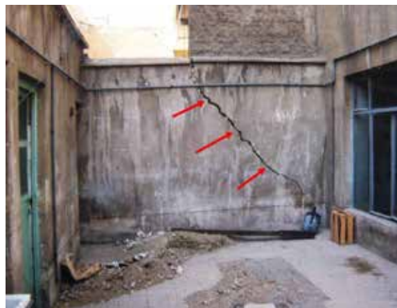
تصویر شماره ۳- ترک های ناشی از نشست ساختمان در دیوار حیاط و در ساختمان مجاور
