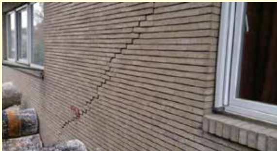
تصویر شماره ۶- ترک ایجاد شده در دیوار، در اثر گودبرداری در نزدیکی ساختمان
