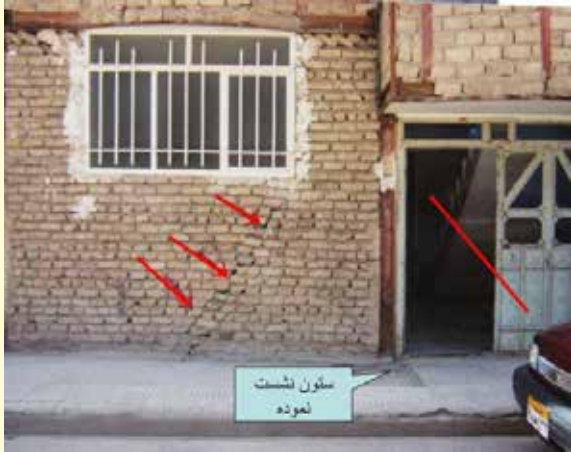
تصویر شماره ۴- ترک ایجاد شده در دیوار خارجی ساختمان، در مجاورت شکستگی لوله آب
