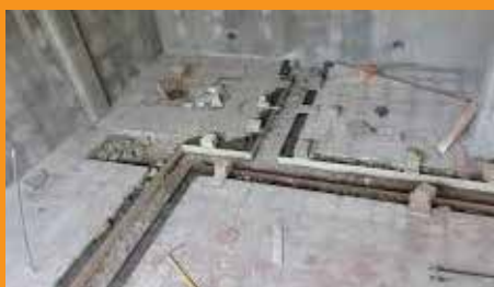
شکل ۲: کانال کشی کف موتورخانه
