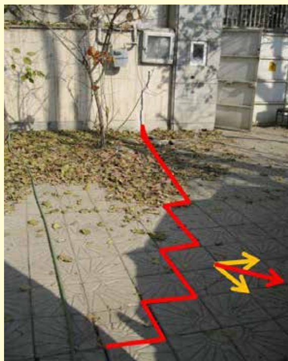
تصویر شماره ۸- ترک ایجاد شده در موزائیک کف حیاط، در اثر گود برداری در نزدیکی ساختمان
