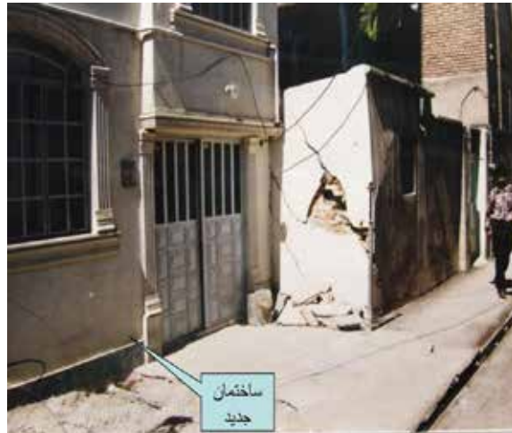
تصویر شماره ۲- ترک ایجاد شده در ساختمان قدیمی در مجاورت ساختمان جدید در اثر نشست طبیعی ساختمان جدید
