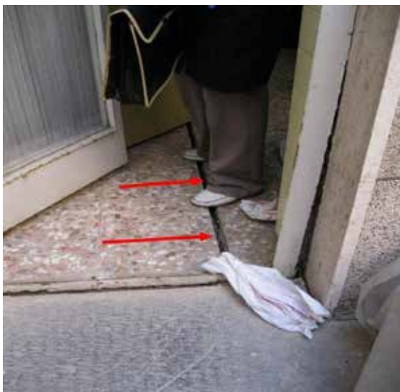
تصویر شماره ۹- ترک در کف ساختمان، در اثر گود برداری در ملک مجاور
