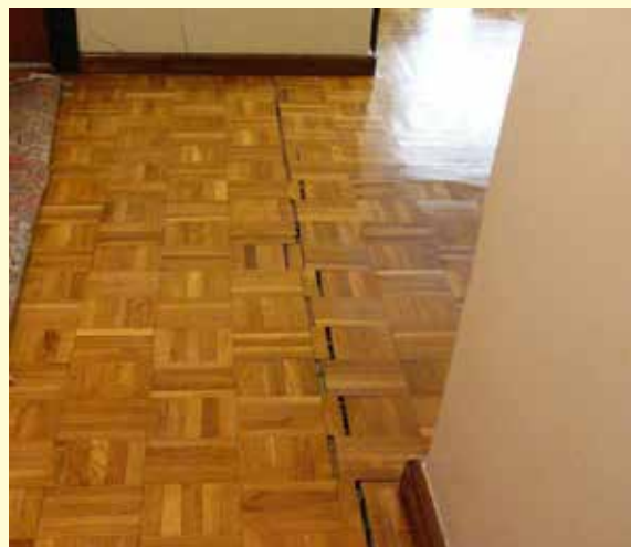
تصویر شماره ۷- ترک ایجاد شده در پارکت، ناشی از گود برداری در نزدیکی ساختمان
