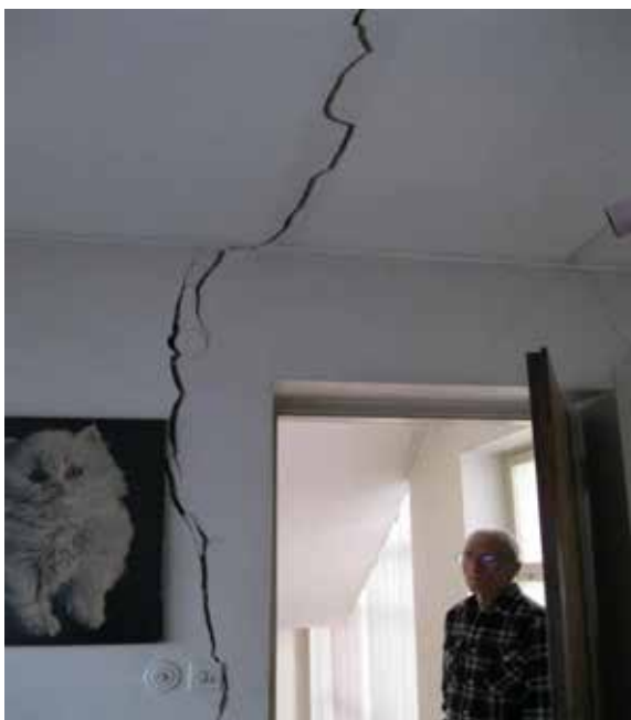
تصویر شماره ۱۰- ترک در دیوار و سقف ساختمان، در اثر گود برداری در ملک مجاور
